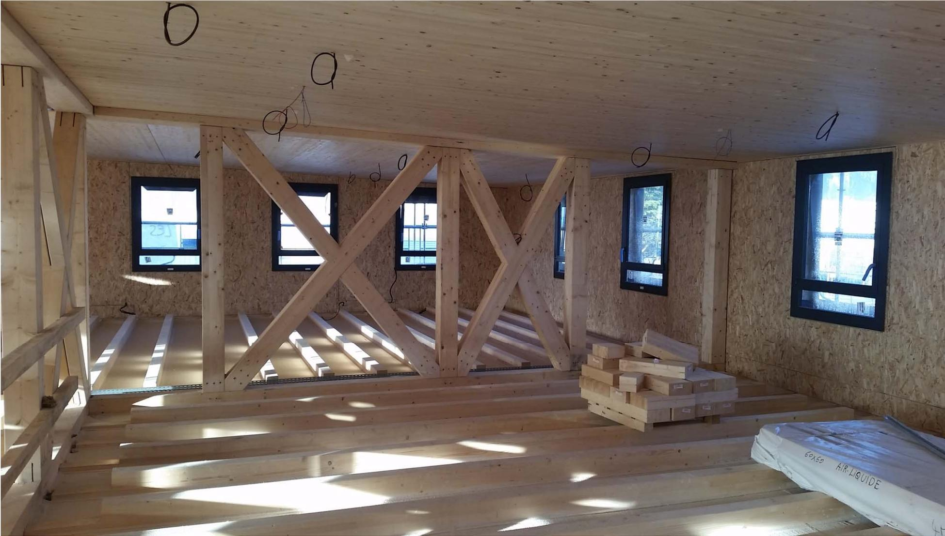
Mise en œuvre du sable = isolement au bruit de chocs =  $L_{NTW} < 60\text{dB}$
