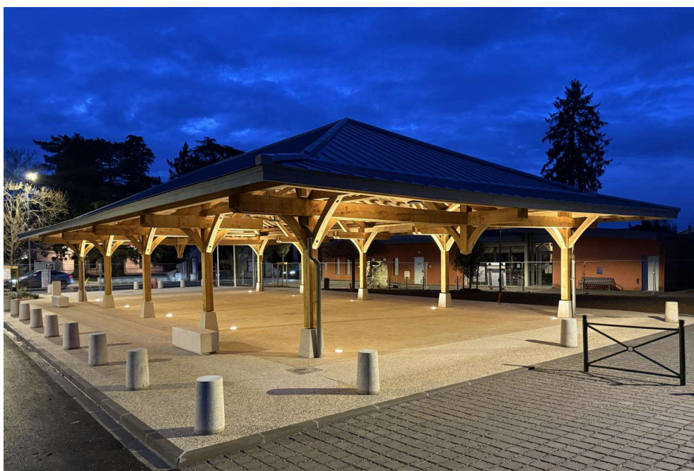
Halle couverte de Villette-d'Anthon - ©Philippe Leplaideur Architecte
