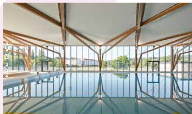
Piscine des balcons du Dauphiné – Morestel
