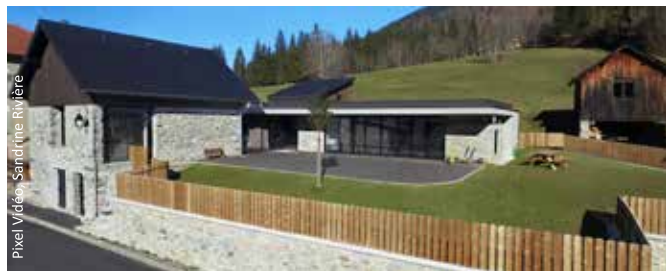
Construction de la nouvelle école primaire et réhabilitation d'une grange patrimoniale
