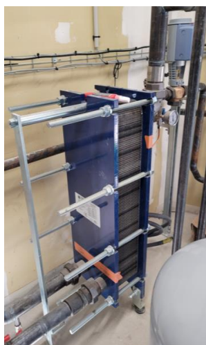
Arrivée du RCU (avant calorifugeage)
