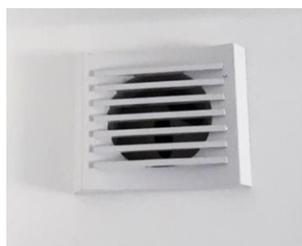
Figure 68 : Illustration de bouches de ventilation des obturateurs permettant l'équilibrage des débits entre les pièces du logement et entre les logements eux-mêmes.
