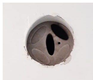
Figure 68 : Illustration de bouches de ventilation des obturateurs permettant l'équilibrage des débits entre les pièces du logement et entre les logements eux-mêmes.
