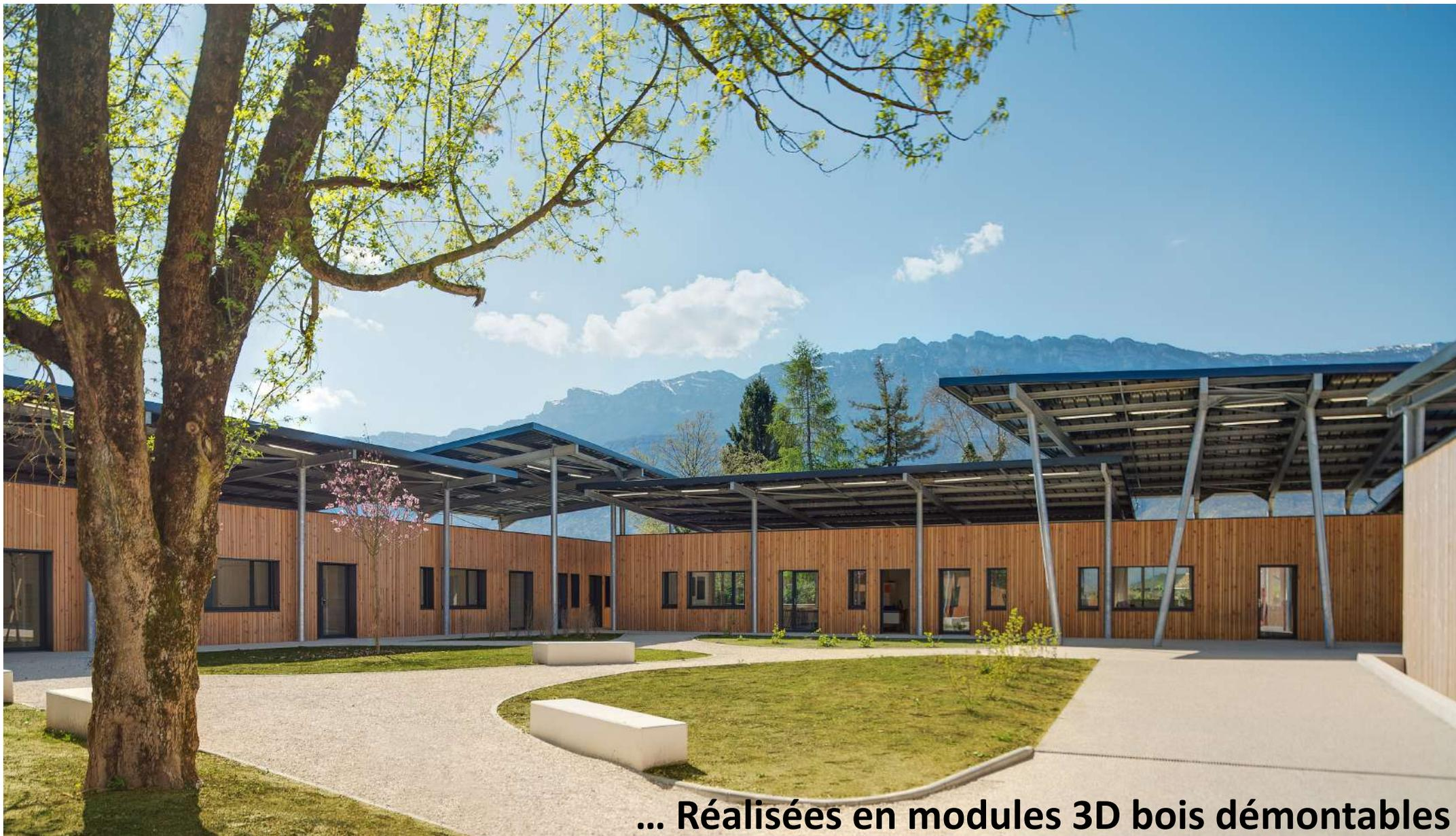
... Réalisées en modules 3D bois démontables
